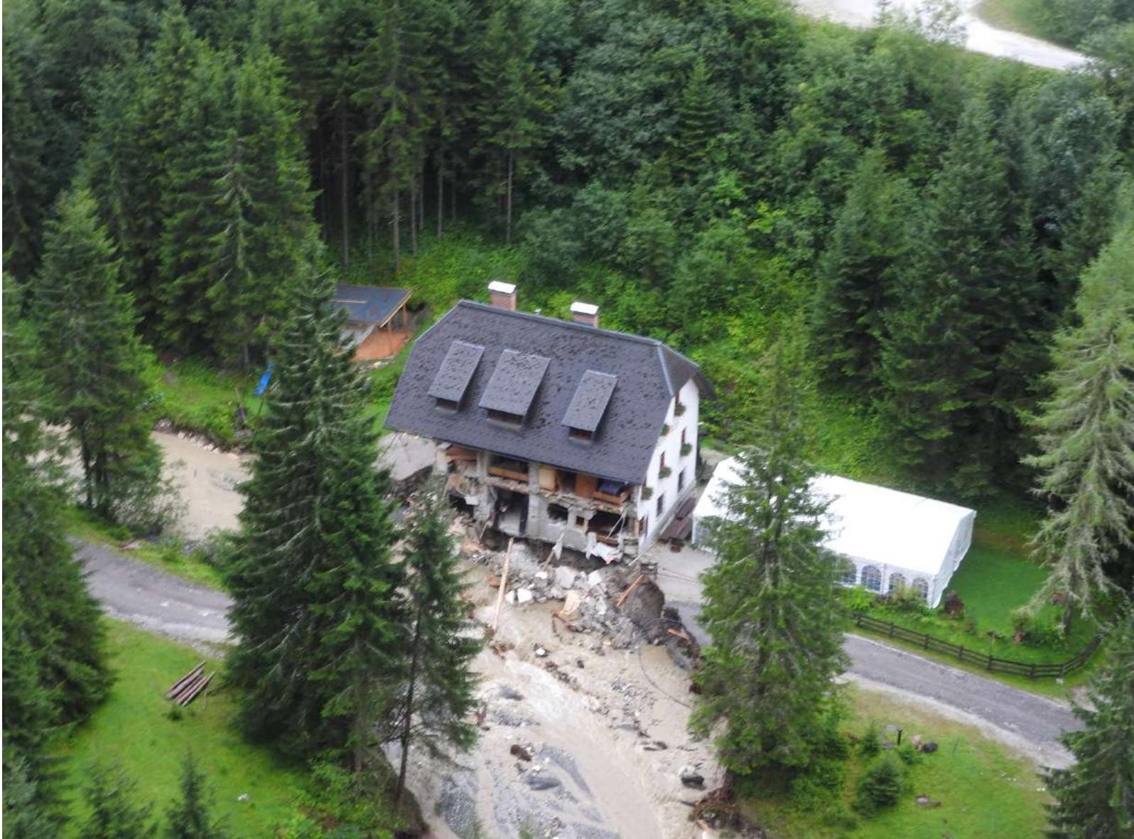
Bild 21: Dieses Haus im Walchental bei Öblarn wurde bei dem gewaltigen Unwetter 2017 durch das Hochwasser im Walchenbach schwer beschädigt. © Wildbach- und Lawinerverbauung (WLV), Forsttechnischer Dienst.
