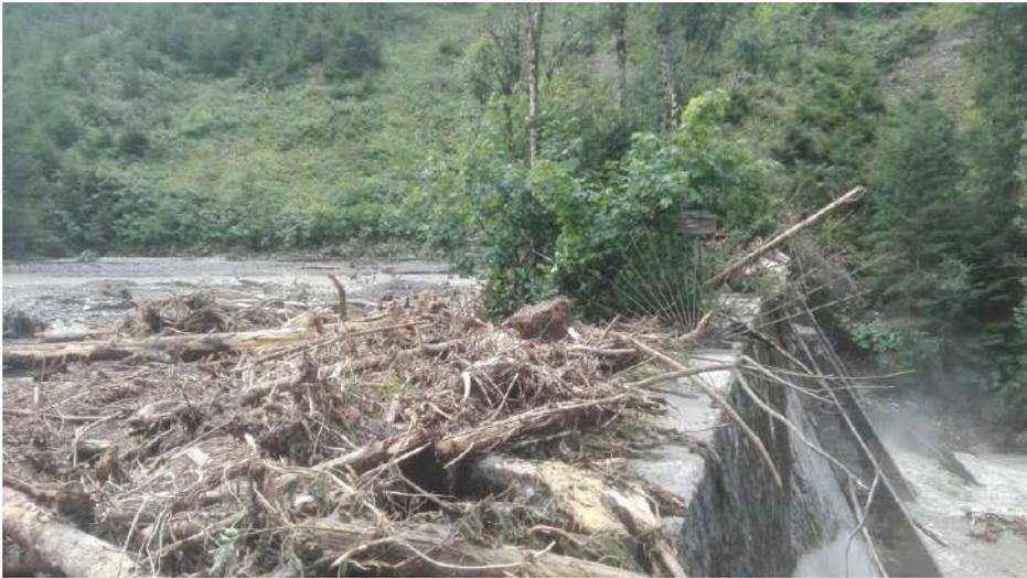
Bild 24: Das Auffangbecken des Murbrecher „Balkensperre“ war randvoll gefüllt. Es hat Schlimmeres bei der Unwetterkatastrophe 2017 für den Ort Öblarn verhindert. © Wildbach- und Lawinenverbauung (WLV), Forsttechnischer Dienst.
